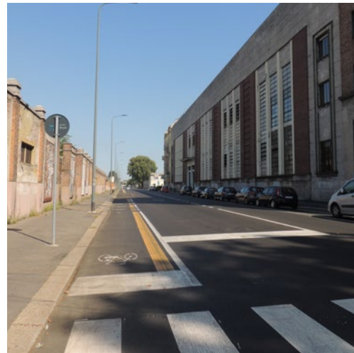
linea avanzata (pista ciclabile in corsia riservata tracciata in carreggiata) intersezione semaforizzata
