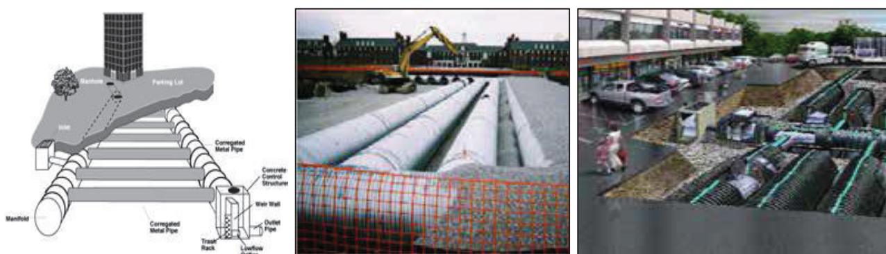
Figura 6-21: Esempio di strutture di laminazione costituite da tubazioni sotterranee e sovradimensionamento del sistema di drenaggio delle superfici impermeabili
