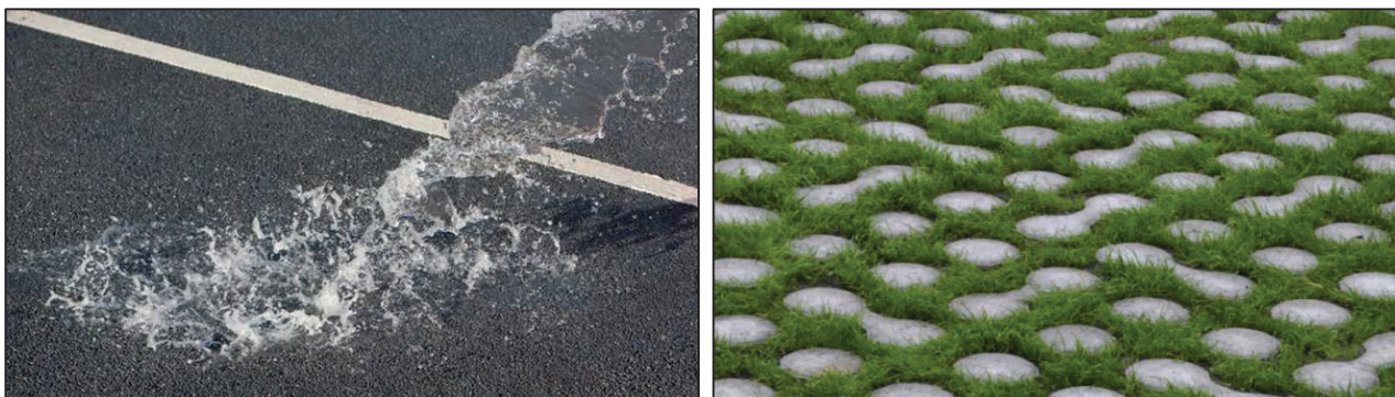
Figura 6-4: Esempi di pavimentazioni permeabili continue e discontinue
