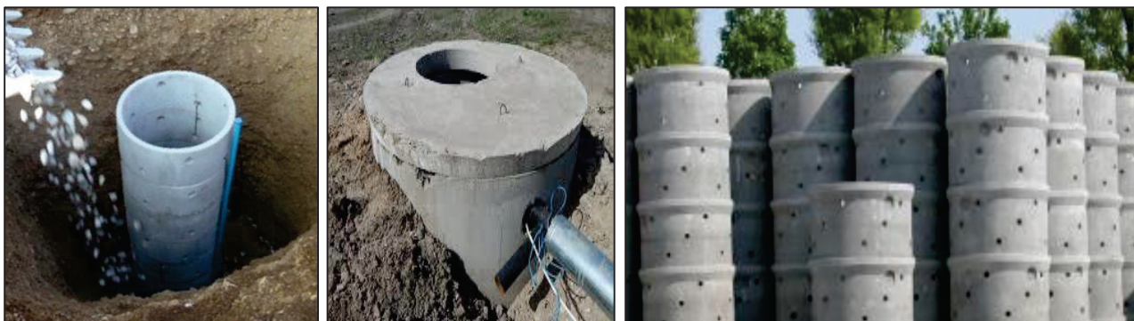
Figura 6-7: Esempio di pozzo d'infiltrazione
