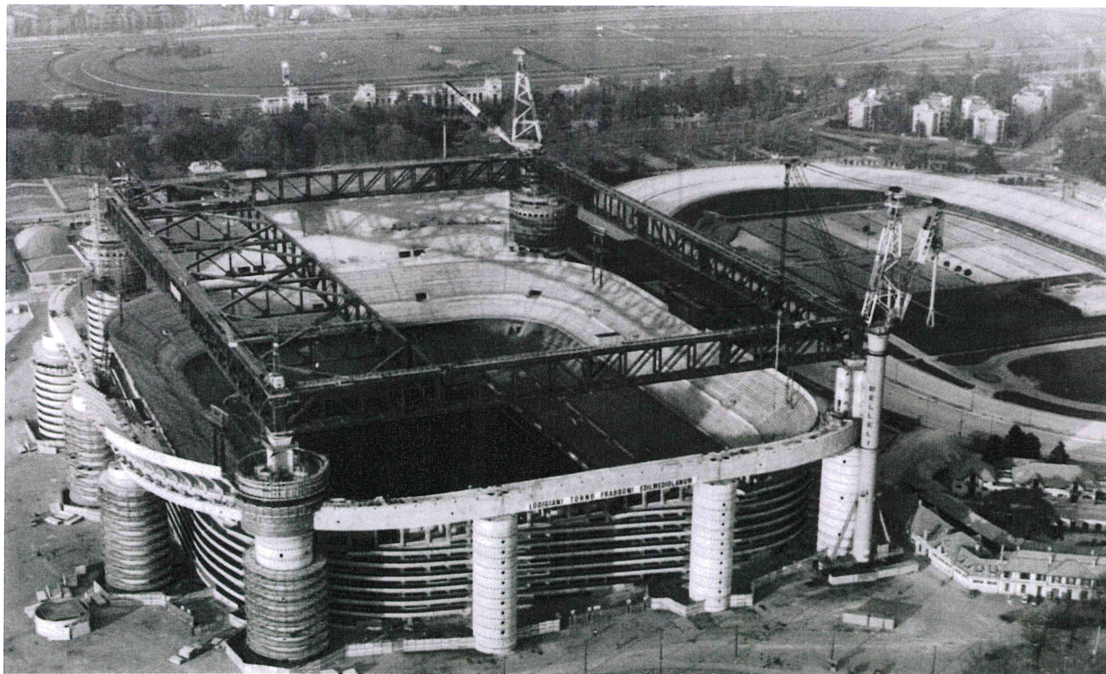
Fig. 20: Foto aerea dell'inizio del montaggio della copertura sulla tribuna ovest
