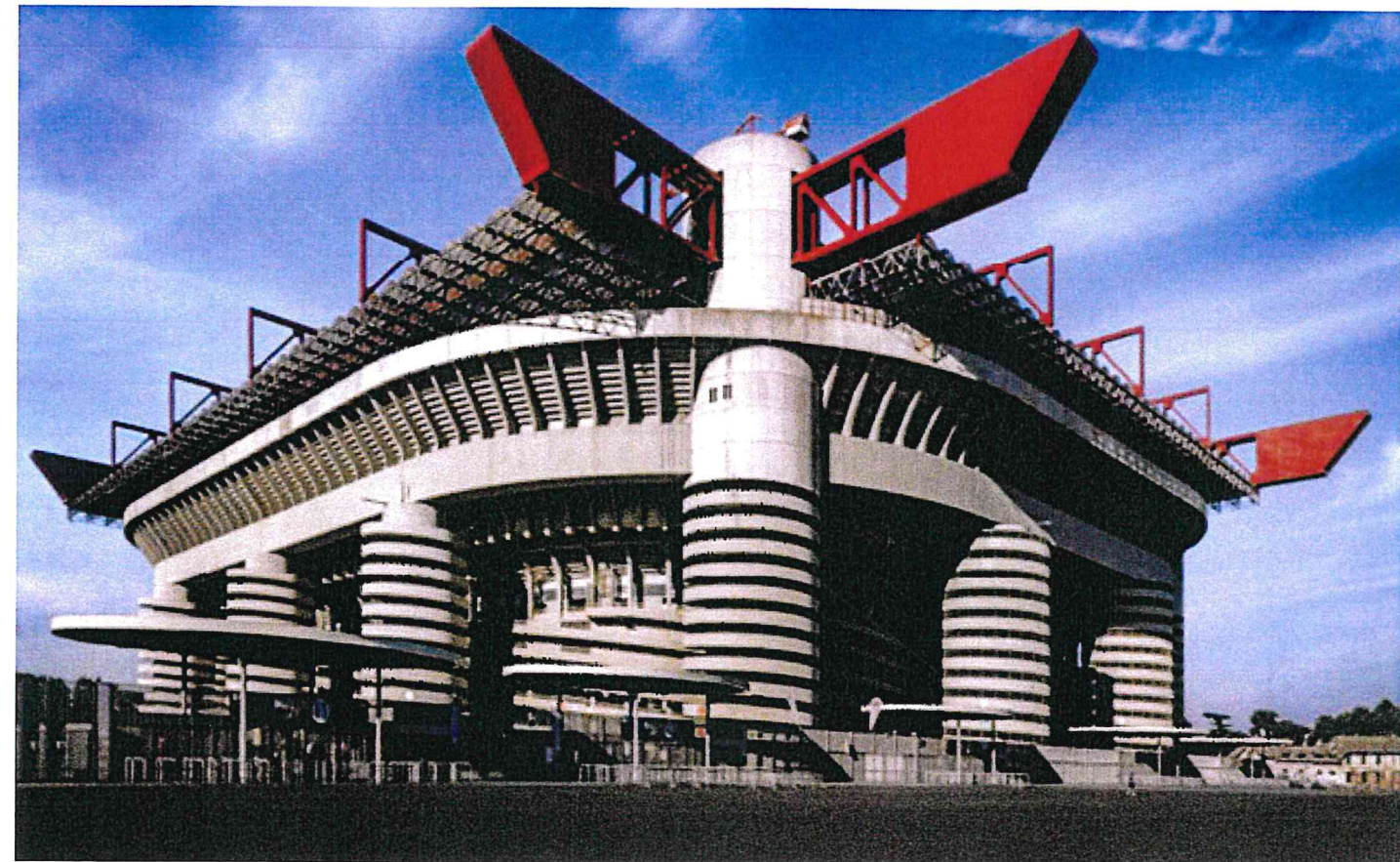
Fig. 02: Stadio Meazza area di servizio annessa
