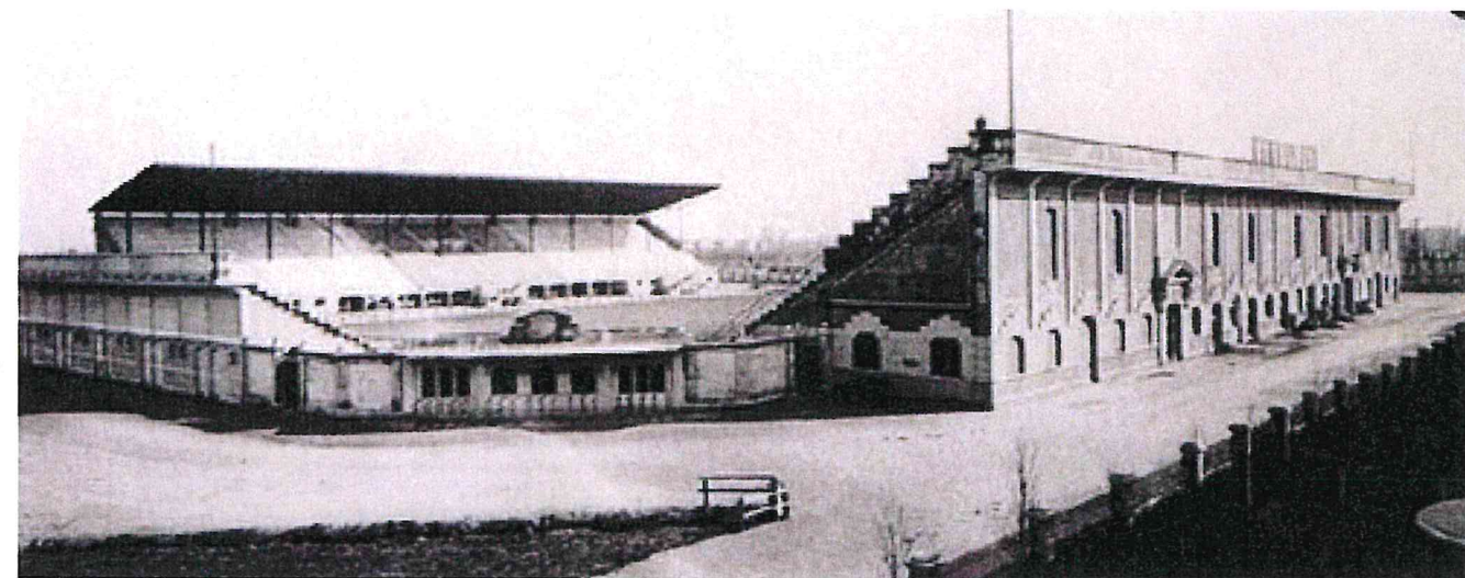
Fig. 03: Vista da via Dessiè
